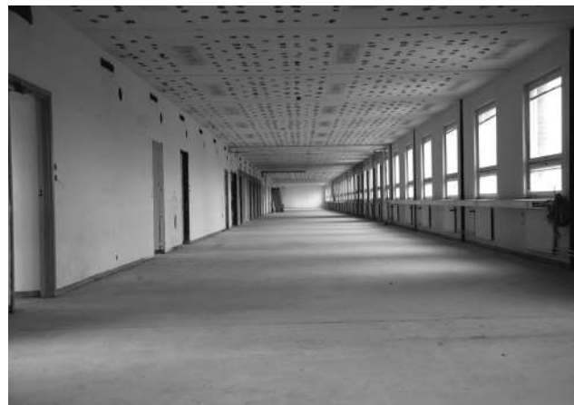
Arkitektskolans ritsalar. Ursprungliga mellanväggar av lättbetong utrivna.
