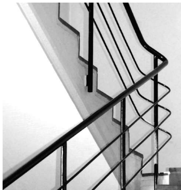
Platsbyggda originalräcken av rörprofiler. Det tunnare smidet av massiv stång.
