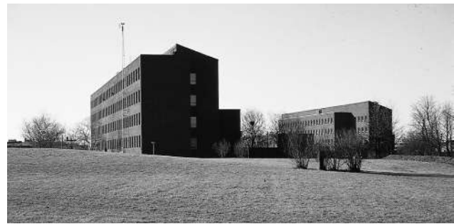
Sektionerna för Arkitektur och Väg- och Vatten från norr.
