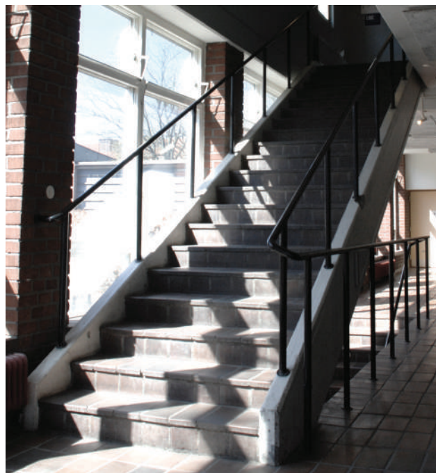
Trappräcken i Matematikhusets hörsalsannex med enbart stolpar och överliggare.
