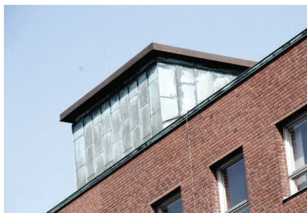
Helt kopparklätt hisstorn. Senare tillkommen kopparplåt i brun nyans.
