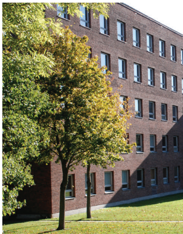
Tegelfasad med vilt förband och så kallade ryska valv över öppningar.
