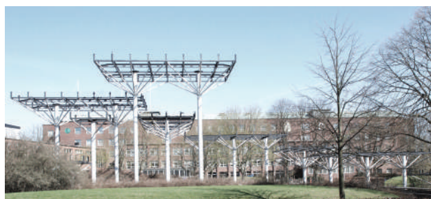
Den delvis demonterade fontänen med E-huset i bakgrunden.
