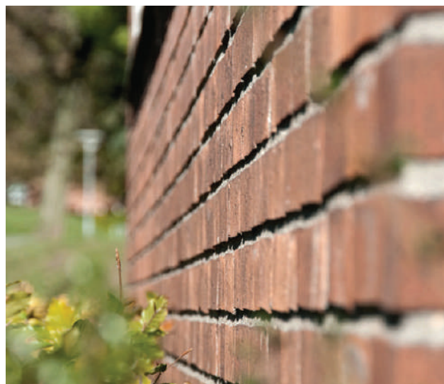
Slottsmöllans röda borstade tegel. Skifthöjd 80 mm - ingen separat fogstrykning.
