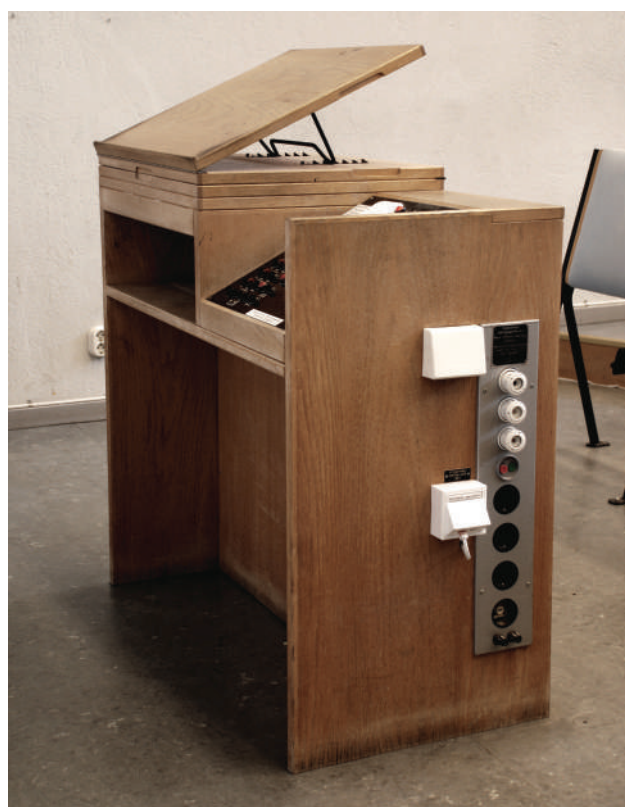
Föreläsarpulpet i hörsal med manöverpanel för mörkläggning och belysning.
