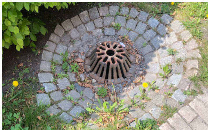
Skiss 2. En dagvattenbrunn kan förses med krage för att att en temporär vattenspegel ska åstadkommas.
