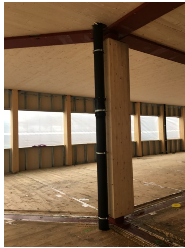
16. Kritiskt läge för pelare i balkkors
