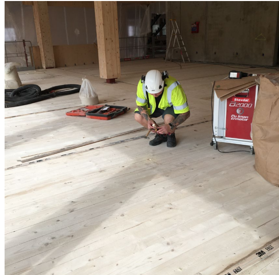
30. Bjälklag efter utförd slipning
