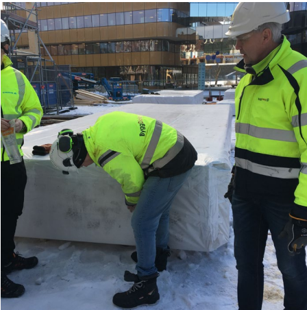
5. Mottagningskontroll m fuktkvotsmätning
