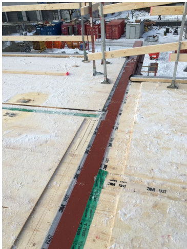
9. Tejp i skarv trä/stålbalk plan 3
