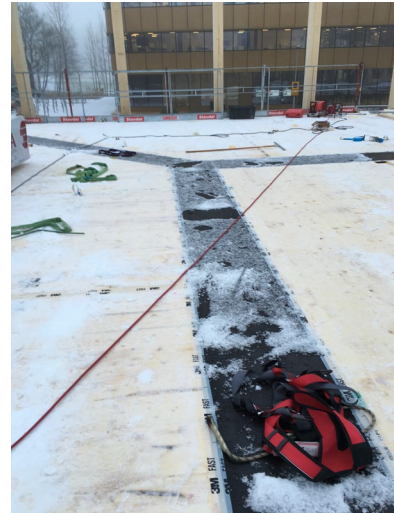
8. Formplywood över balk och tejp plan 2
