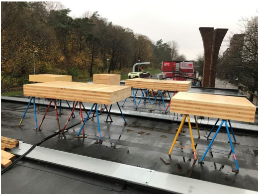
1. Test av KL-trä på bodetablringens tak
