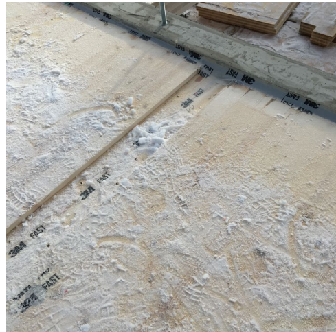
10. Tejp i skarv mellan element och trä/betong
