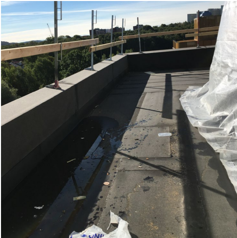
22. Utförande av underlagspapp på terrass
